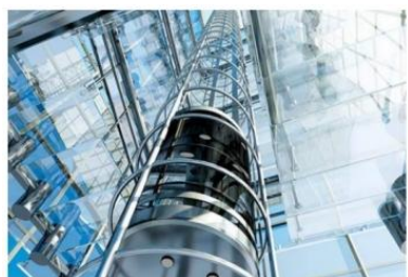
奥的斯电梯照明控制箱项目
