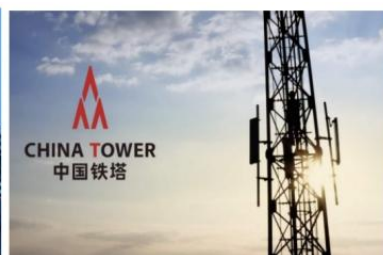
安徽铁塔 2024 年精准直流配电设备增补采购项目
