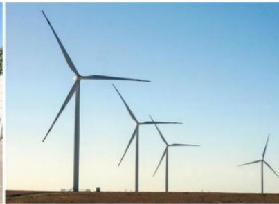
神木中能建巨皇新能源佳县 150兆瓦风电项目
